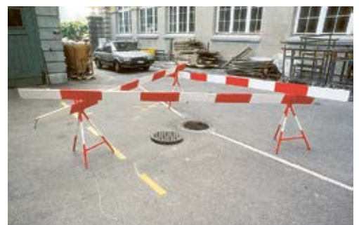
10 Absperrung eines Schachts
