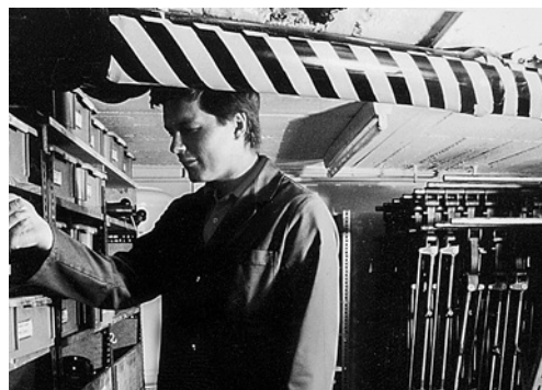
5 Ablaufrohr neben Lagergestell, mit gelb-schwarz markiertem Schaumgummi gepolstert.
