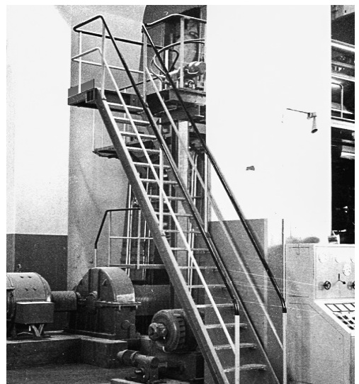
4 Steiltreppe, beidseitig mit Geländern versehen.
